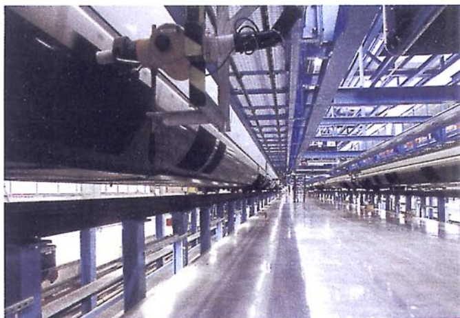
Bild 1. Seinen charakteristischen Glanz hat dieser mit Ashford Formula® verdichtete Betonboden in einer ICE-Wartungshalle der Deutschen Bahn AG entwickelt
