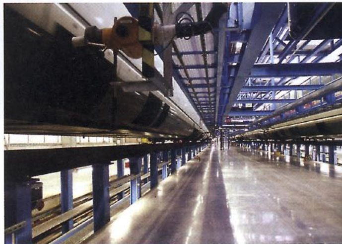
Der Industrieboden in einer ICE-Wartungshalle der DB AG sollte ursprünglich als kunstharzbeschichtete ableitfähige Fläche ausgeführt werden. Der Einsatz von Ashford Formula® minimierte das Risiko für den Planer und die Kosten für den Bauherrn.
