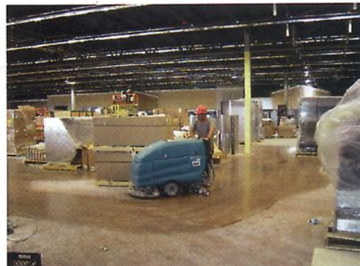
Während der Bauphase wird der Prozess der chemischen Betonverdichtung durch den Einsatz von Wasser und Reinigungsmaschinen beschleunigt.
