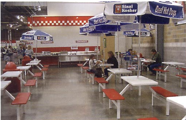
Chemisch verdichtete Betonböden sind resistent gegen Speisereste und Zigarettenglut und einfach zu reinigen
