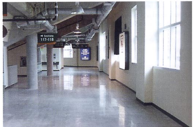
Bild 2. Glänzende Betonböden im Convocation Center der University of Miami auf dem Campus Coral Gables in Florida nach der Behandlung mit dem Retroplate-System. (Fotos: Apogee Distribution)
