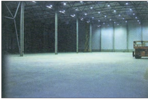
Bild 3. Erste Lagerhalle mit fertigem Industrieboden im Logistikzentrum Kaunas (Bilder: Peikko Deutschland)
