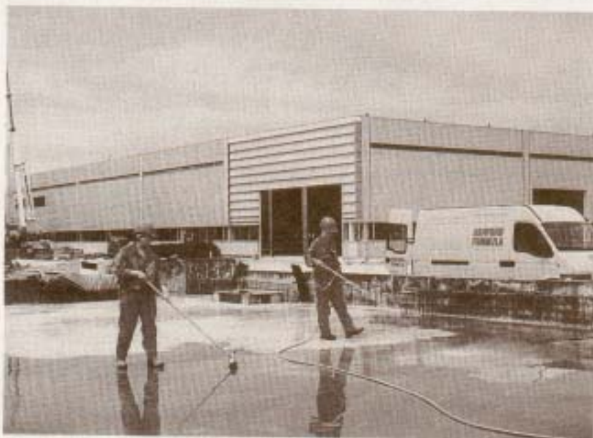
DaimlerChrysler vertraut bei seinen Betonböden in Kölleda auf das Verfahren Ashford Formula. Foto: Norsa
