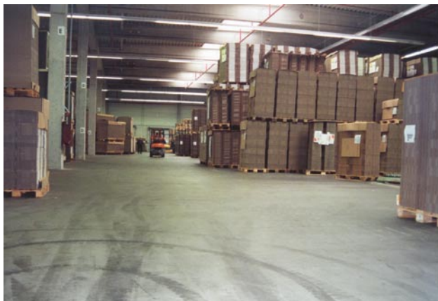
Bild links: Mechanische Beanspruchung von Betonböden führt zu Abnutzung und Staubbildung. Bild rechts: Hochfeste Ashford-Böden sind dauerhaft abriebfest und entwickeln bei einfacher Nasspflege einen charakteristischen Glanz.
