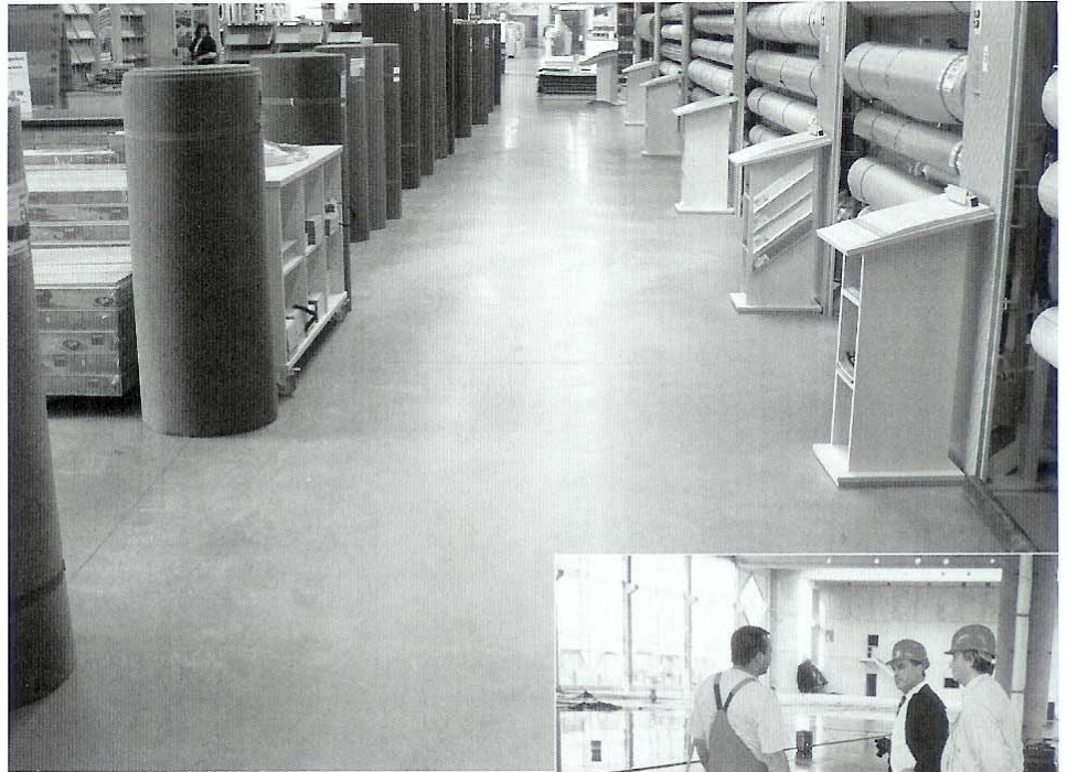
Boden eines Verkaufsraums mit chemischer Betonverdichtung durch Ashford Formula.
