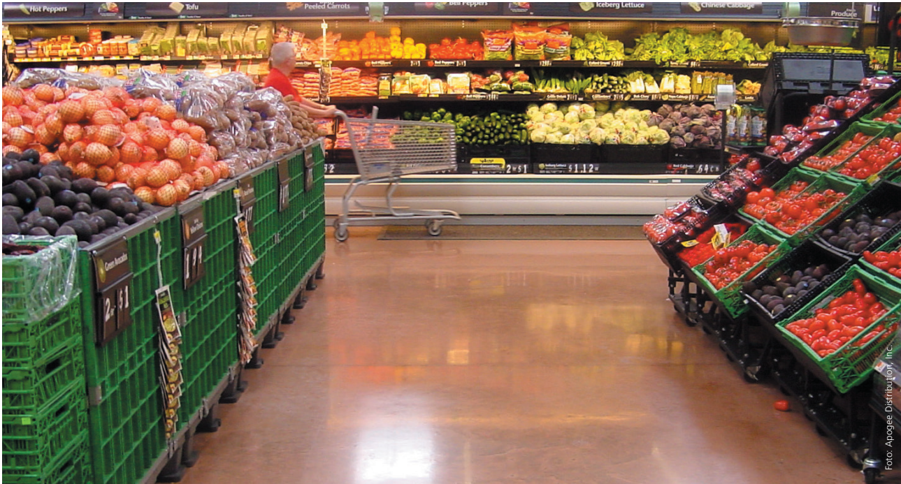
Wal-Mart Supercenter, Tampa FL, USA 15.000m 2 , 2004, eingefärbter Betonboden, intensive Nassreinigung während der Bauphase
