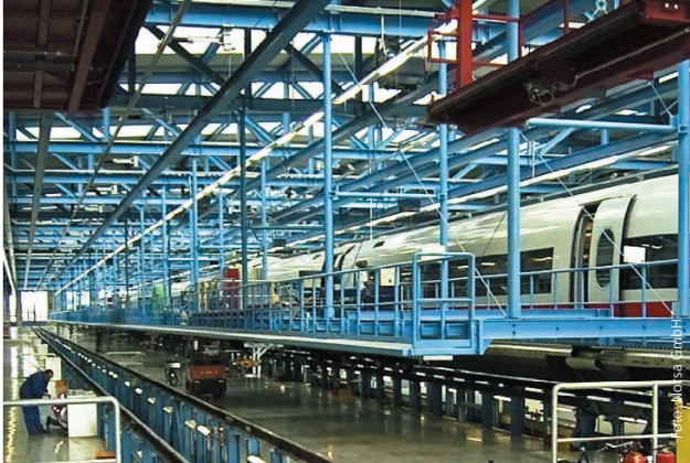
Deutsche Bahn, Wartungshalle
